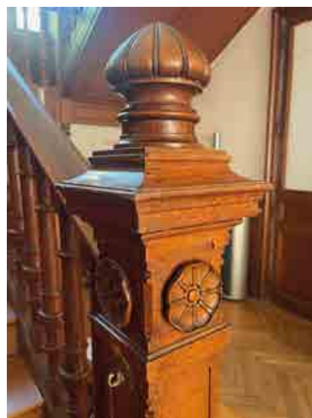
Détail de la rampe
