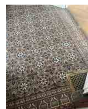
Carrelage en ciment à motif géométrique en étoile et grille d'aération en laiton
