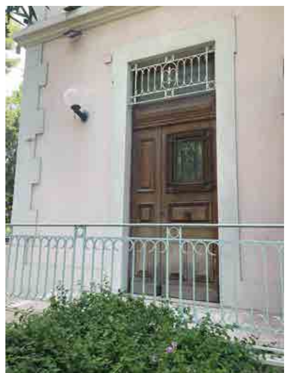
(4) L'entrée de service du rez-de chaussée
